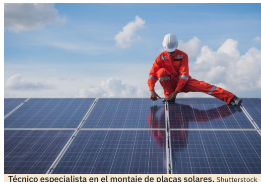
Técnico especialista en el montaje de placas solares. Shutterstock
